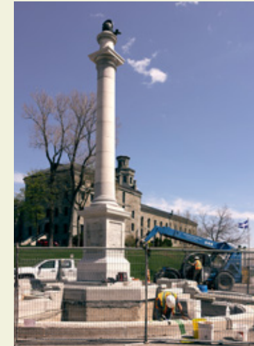
Travaux de restauration du monument Wolfe
